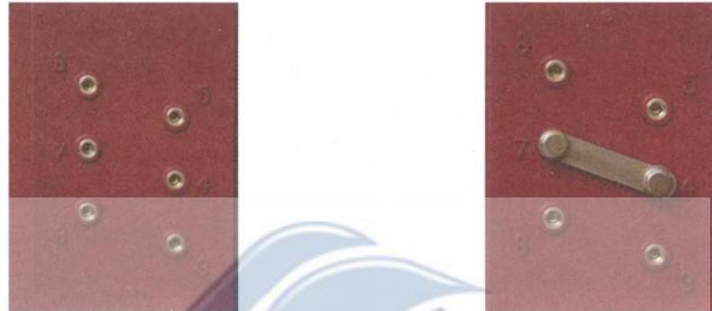
شکل ۶ - خروجیهای تنظیم ولتاژ در بین فشار قوی
